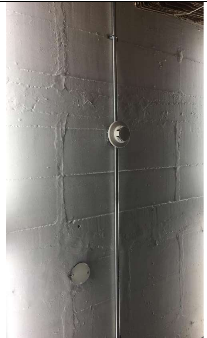
Ilustración 4. Distribución Red Sistema de Detección de incendio
