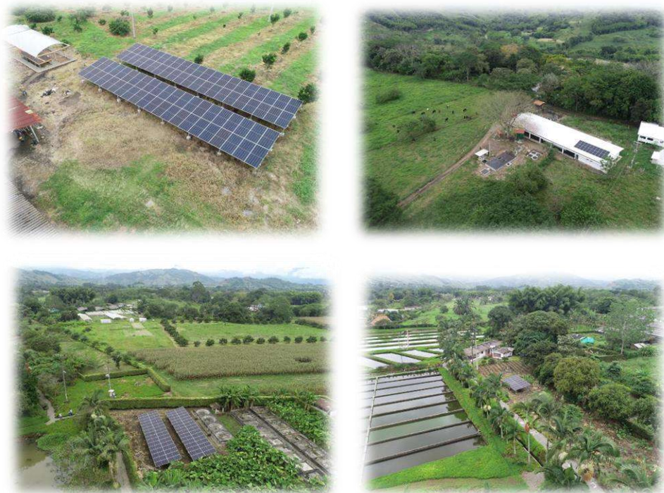
Ilustración 34 Proyecto piloto de paneles solares
